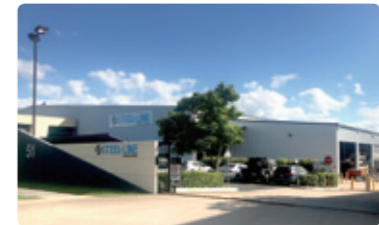
BX BUNKA AUSTRALIA PTY LTDの工場
