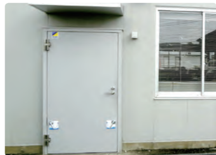
1号館通用口に設置された止水ドア「アクアード」
