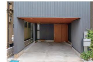
狭小地に建つ耐震等級3の木造3階建て住宅。ベースセッターを車庫の片側に配置し、広い駐車スペースと玄関へのアプローチを確保
