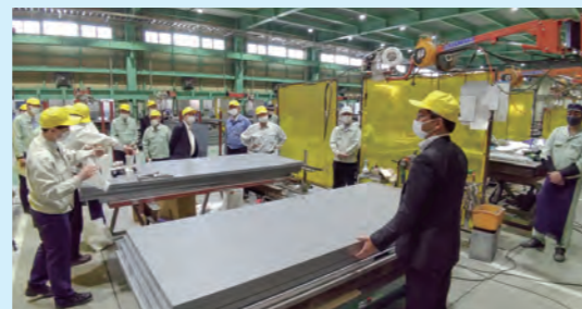
国土交通省の立ち会いによる接着工法検証確認の様子
